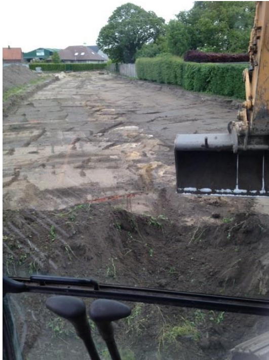
Figuur 3: Afgraven van zwarte grond, om een mooi vlak werkgebied te creëren
