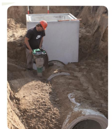
Figuur 14: Verdichten van de sleuf
