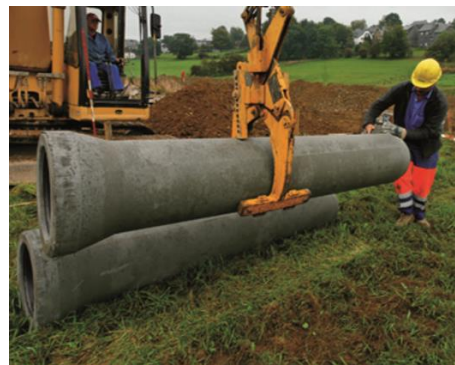
Figuur 7: Hijzen met buizenklem
