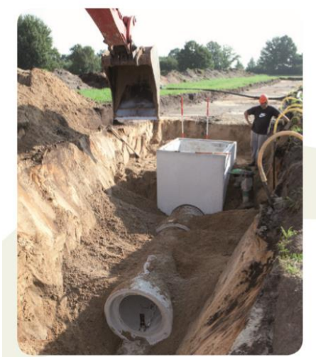
Figuur 13: Aanvullen van de sleuf
