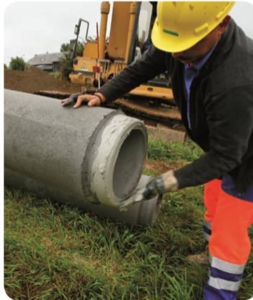
Figuur 8: Glijmiddel aanbrengen
