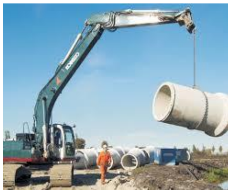
Figuur 6: Hijzen met buizenketting
