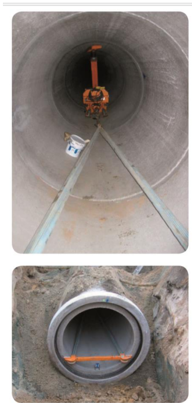
Figuur 11: Ineenschuiven van betonbuizen met een trekwerktuig
