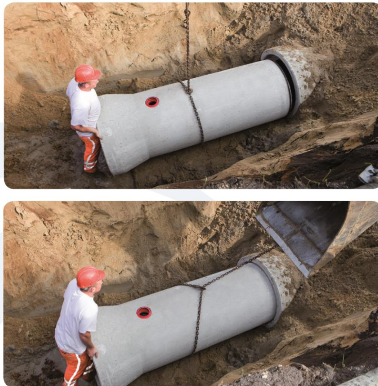
Figuur 10: Ineenschuiven van betonbuizen met buizenketting
