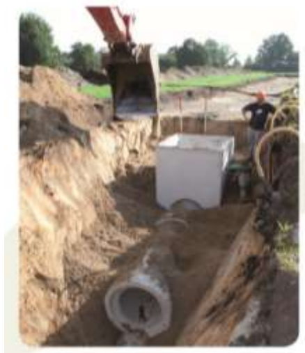
Figuur 13: Aanvullen van de sleuf
