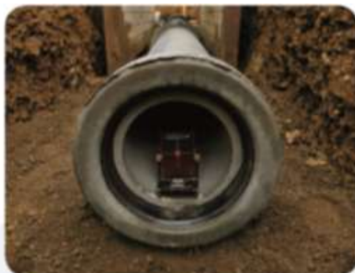
Figuur 12: Gebruik van een buizenlaser
