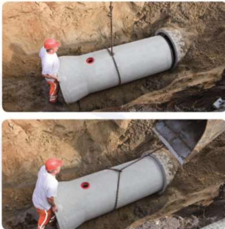
Figuur 10: Ineenschuiven van betonbuizen met buizenketting
