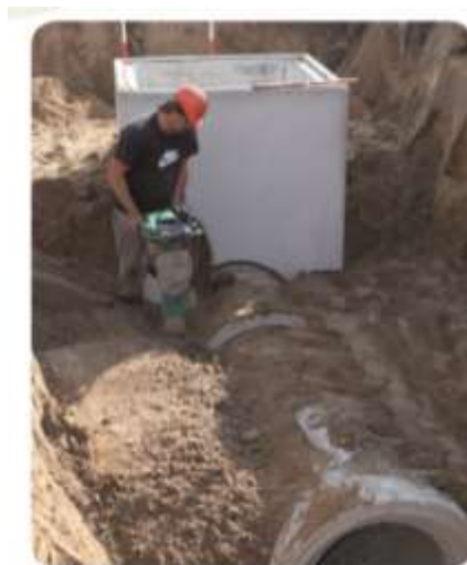
Figuur 14: Verdichten van de sleuf
