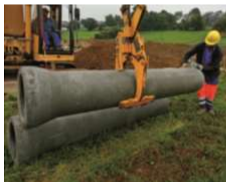
Figuur 7: Hijsen met buizenklem
