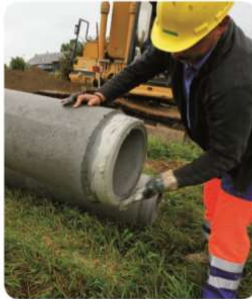
Figuur 8: Glijmiddel aanbrengen
