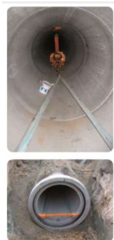
Figuur 11: Ineenschuiven van betonbuizen met een trekwerktuig
