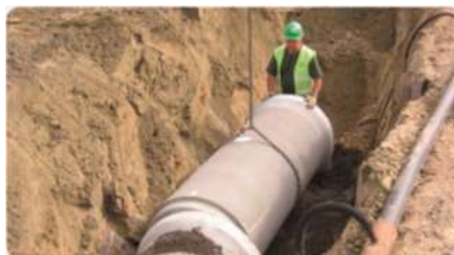
Figuur 9: Buizen plaatsen in de sleuf
