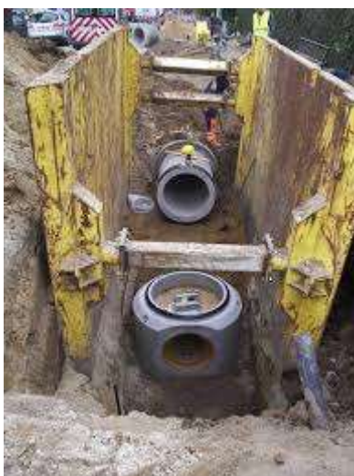
Figuur 4: Beschoeiingssysteem
